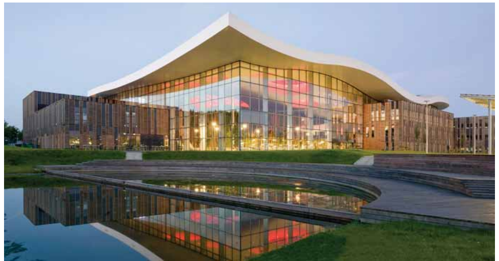
Elk materiaal in het Liander-gebouw heeft een 'paspoort' gekregen, zodat het in stukjes uit elkaar kan worden gehaald. 'Ik ga alleen nog in zee met partijen die op die manier willen werken.'
