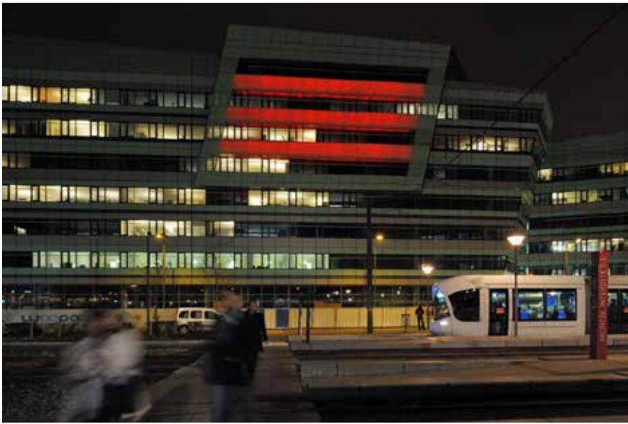
Woopa Lyon is een van de eerste grote energieleverende gebouwen ter wereld. In de zomermaanden voorkomt de ademende gevel met geïntegreerde zonwering oververhitting van het binnenklimaat. Terugwijkende getrapte gevels zorgen voor zelfbeschaduwing. De oriëntatie van het gebouw zorgt voor een optimaal rendement van de in het dak geïntegreerde PV cellen.
